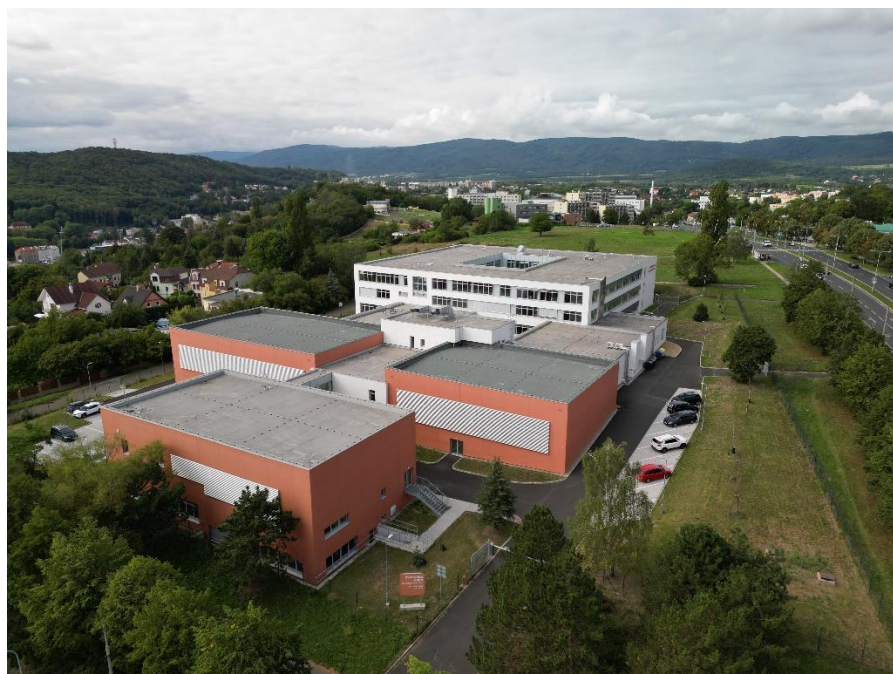
Nová budova „B“ – střední odborná škola (Stará 99, Ústí nad Labem)
